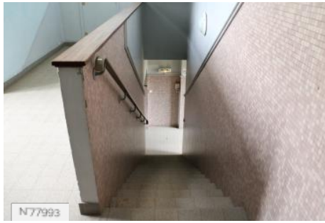
La maison d'Education des Loges - Escalier n°3
