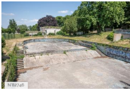
Village éducatif Saint-Philippe - Ancienne piscine
