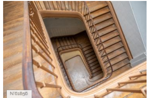
Village éducatif Saint-Philippe - Escaliers
