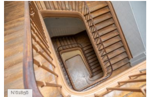
Village éducatif Saint-Philippe - Escaliers
