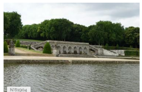
N°01904 Château de Vaux-le-Vicomte - Grottes et terrasse
