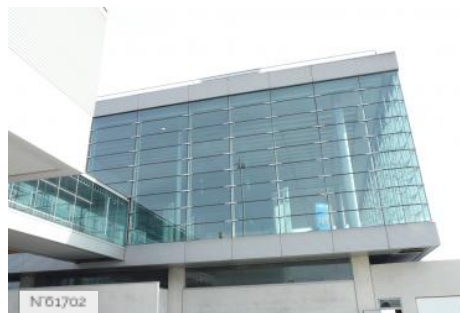
Aéroport Paris Charles de Gaulle - Terminal S3
