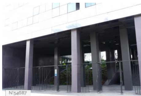
Université Paris Diderot Paris 7 - Lavoisier bâtiment extérieur
