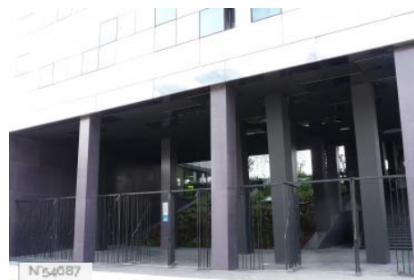
Université Paris Diderot Paris 7 - Lavoisier bâtiment extérieur
