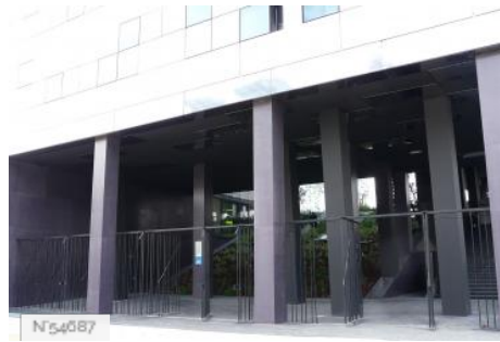
Université Paris Diderot Paris 7 - Lavoisier bâtiment extérieur
