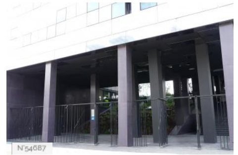
Université Paris Diderot Paris 7 - Lavoisier bâtiment extérieur
