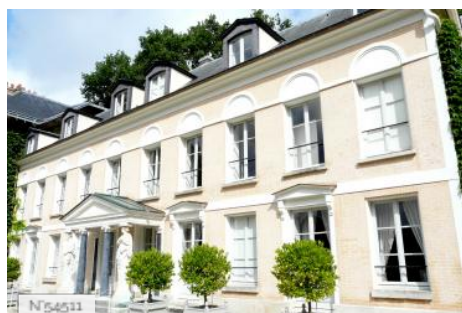
Maison de Chateaubriand - Extérieurs
