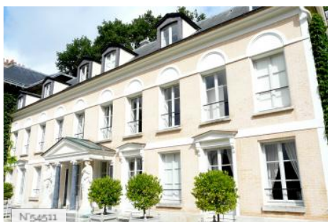
Maison de Chateaubriand - Extérieurs
