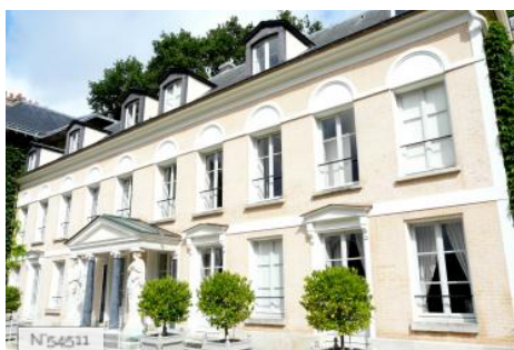
Maison de Chateaubriand - Extérieurs
