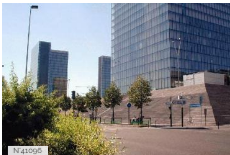
BNF Site François Mitterrand - Bâtiment extérieur
