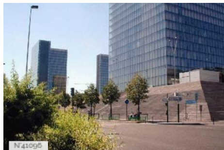
BNF Site François Mitterrand - Bâtiment extérieur
