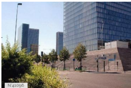
BNF Site François Mitterrand - Bâtiment extérieur
