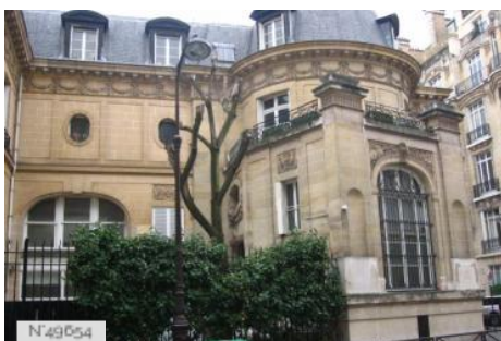
Lycée Octave Feuillet - Façade
