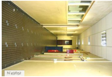
Lycée Octave Feuillet - Couloir
