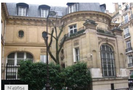
N°49654 Lycée Octave Feuillet - Façade
