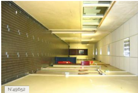
N°49652 Lycée Octave Feuillet - Couloir
