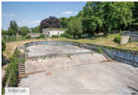
Village éducatif Saint-Philippe - Ancienne piscine
