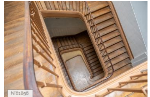
N°01856 Village éducatif Saint-Philippe - Escaliers
