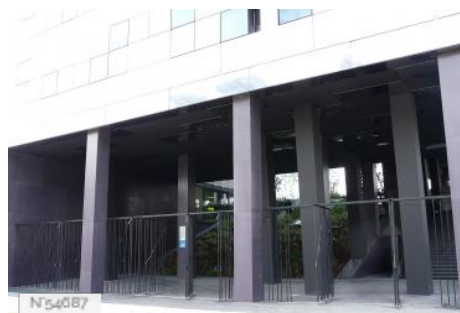
Université Paris Diderot Paris 7 - Lavoisier bâtiment extérieur
