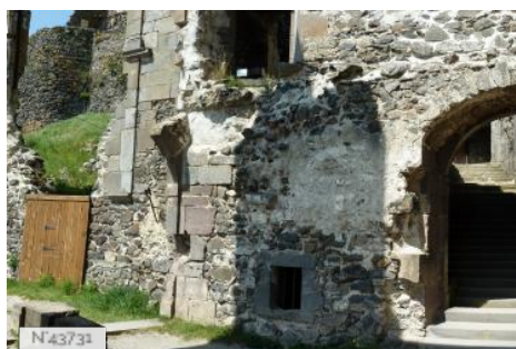
Château de Murol - Accès cour intérieure
