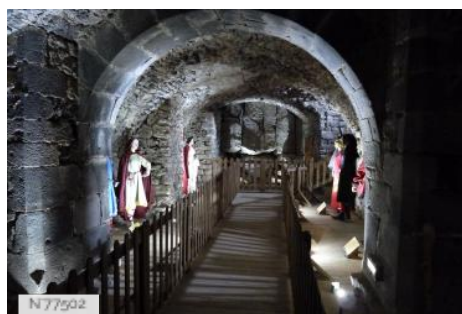
Château de Murol - Cellier
