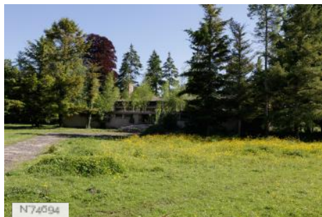
Château Le Kinnor - Bâtiments en rénovation
