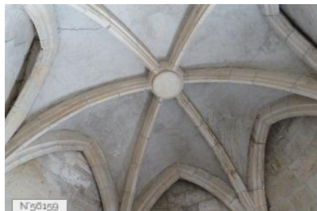
Mal Coiffée - Ancienne Prison - Bureaux 1er Etage - Moulins
