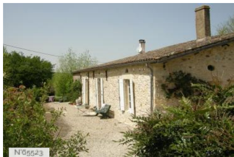
Maison Pruera Ancienne Ferme
