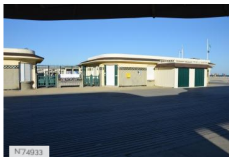
Les bains pompéiens de Deauville
